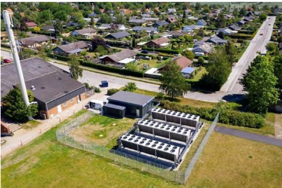
Abbildung 44: 1 MW th Luftwärmepumpe in Dänemark (Urheber PlanEnergi)
