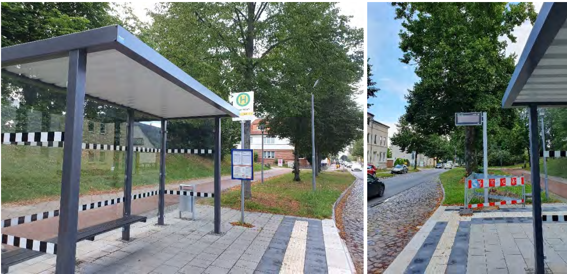
Abbildung 86: Barrierefrei ausgebaute Haltestelle „Plauer Straße“ (stadteinwärts) mit Fahrgastunterstand und Sitzmöglichkeit, Sonderborde, Bodenindikatoren, Fahrplanaushang, Abfalleimer sowie zusätzlicher digitaler Anzeigetafel (Quelle: ZEBAU GmbH)
